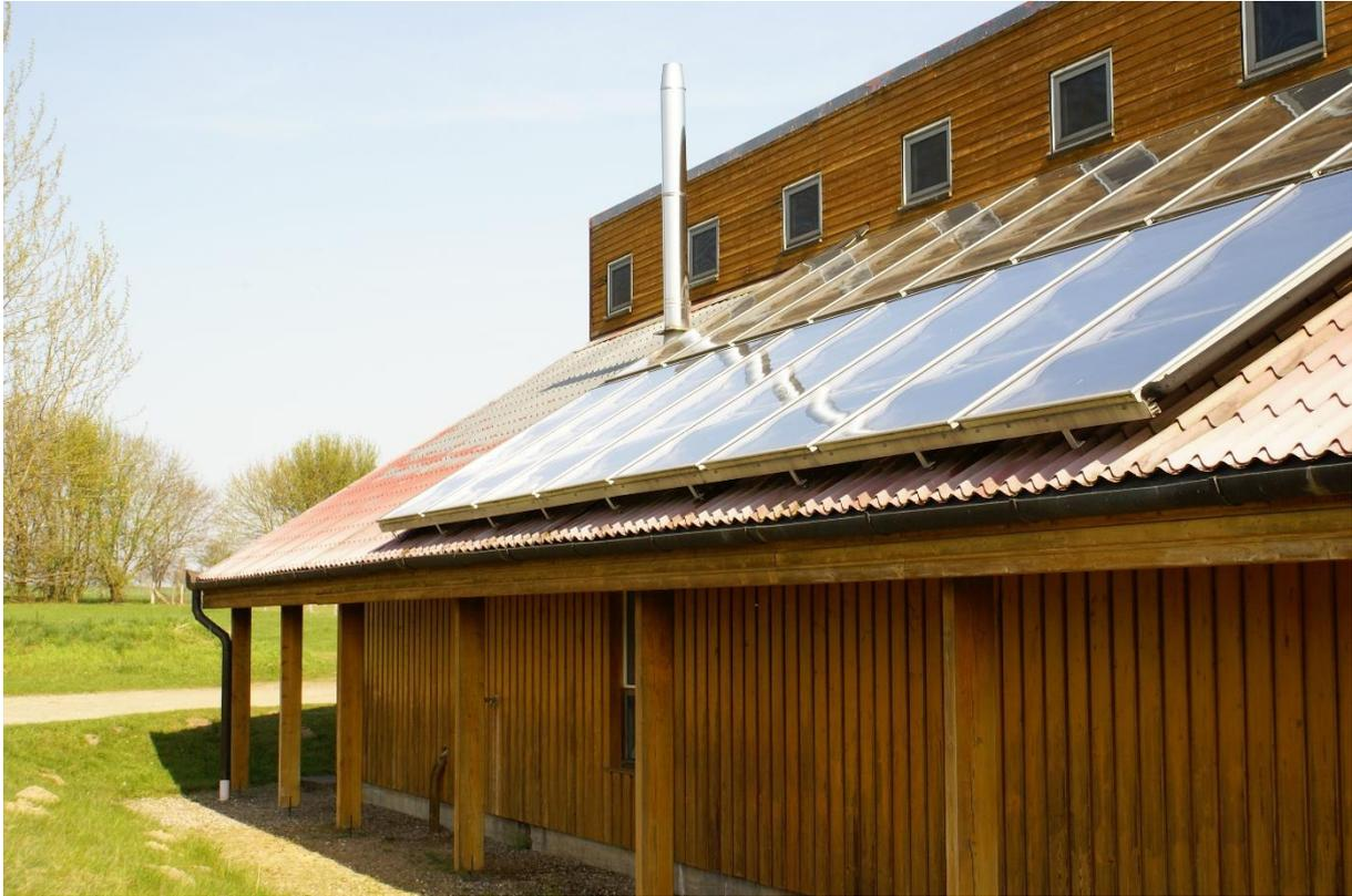
*BU: Solarkollektoren sorgen für Warmwasser und Holzvergaser für eine warme Heizung. In Zukunft will der Ferienpark auch seinen Strom zu 100 % selbst aus erneuerbaren Energien erzeugen (Foto: Campingplatz Seehof GmbH)*
