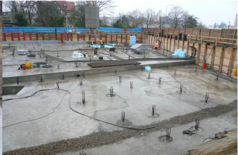
**Sammelleitungen von den Pfählen zu einem Geothermieschacht**
