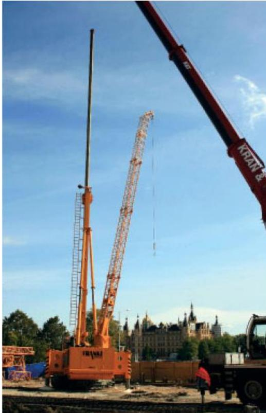
Atlas-Pfahlbohrgerät mit ausgefahrener Verrohrung
