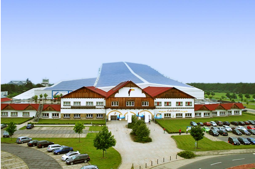
BU: alpincenter Wittenburg nutzt PV und Biogas für die nachhaltige Stromversorgung (Foto: Hotel Hamburg-Wittenburg van der Valk GmbH)
