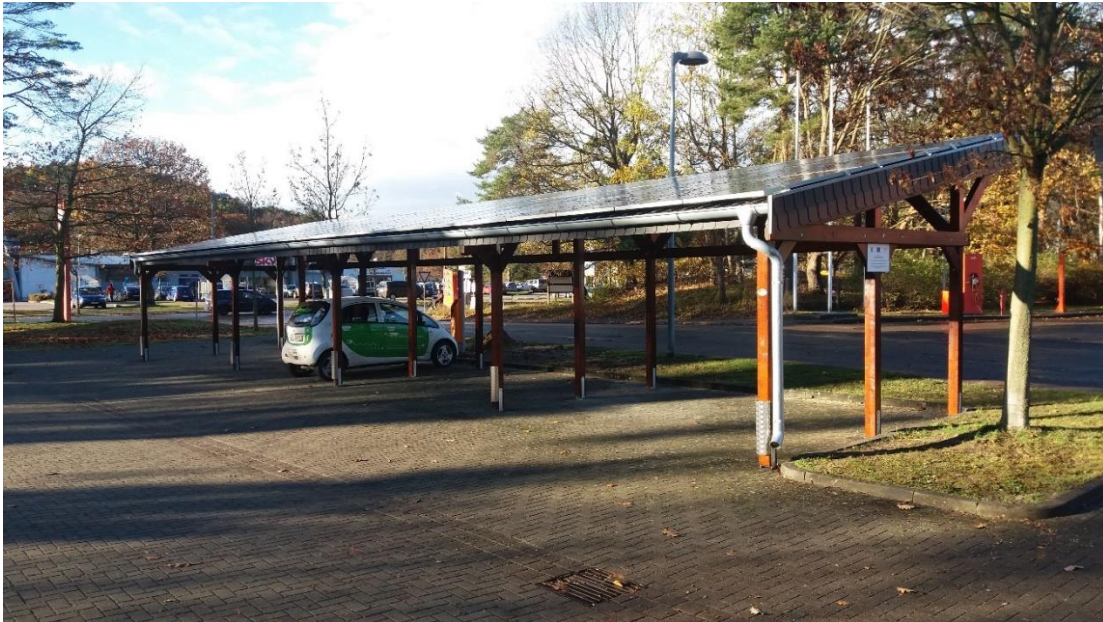
BU: Erneuerbare Energien und Elektromobilität: So könnte eine auf Solar basierende Ladestation für E-Mobile aussehen (Foto: Inselwerke eG)
