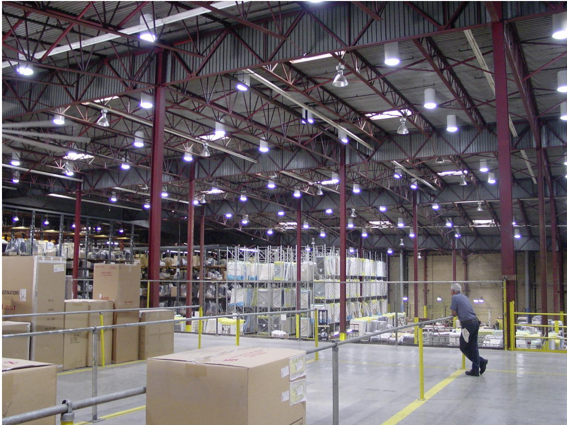
BU: Lagerhalle ausgestattet mit energiesparenden Solatube Lichtlenksystemen (Foto: Interferenz Daylight GmbH)
