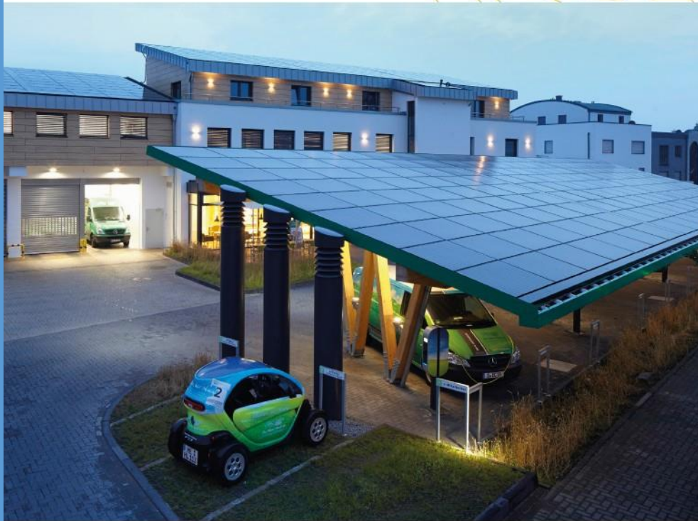
Abbildung 1: Beispiel für ein mögliches PV-Eigenverbrauchs-konzept zum Laden von firmeneigenen E-Fahrzeugen sowie privaten Mitarbeiterfahrzeugen und Kundenfahrzeugen
