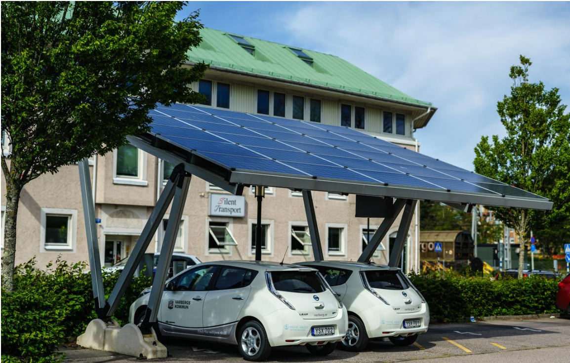
BU: Kosten senken und Klima schützen: PV-Anlage zum Laden des E-Fuhrparks nutzen (Foto: Shutterstock).
