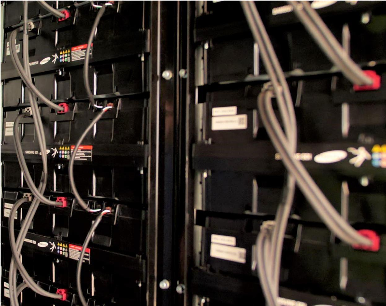
*BU: Batteriespeicher als Lösung für fluktuierende Stromerzeugung aus PV- und Windenergieanlagen sowie teure Lastspitzen (Foto: LEKA MV)*
