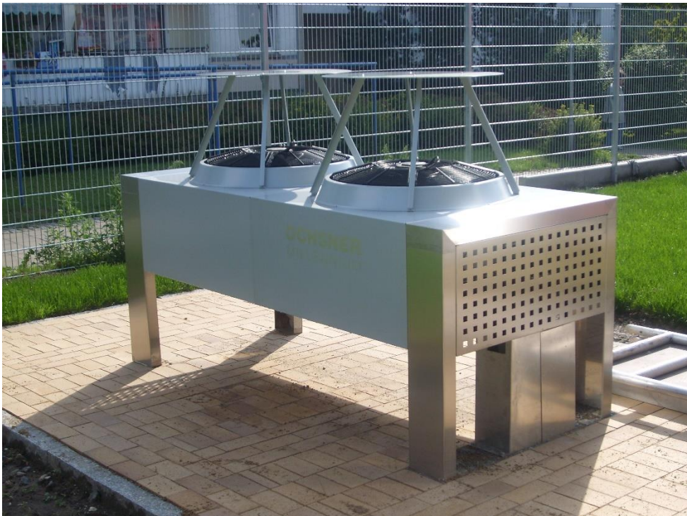
BU: Beispiel einer Luftwärmepumpe für die gewerbliche Nutzung (Foto: LEKA MV/A. Rakel)
