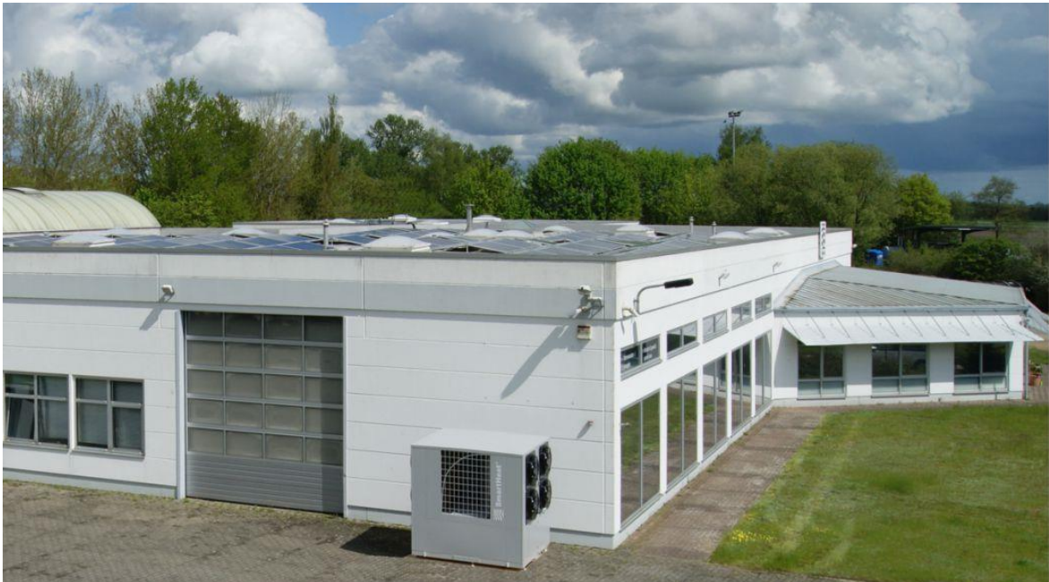
BU: Wie Alt- und Bestandsbauten mit Wärmepumpen beheizt werden können zeigt der MVeﬃzient-Stammtisch am 28.06.2022 ab 17:00 Uhr (Foto: SmartHeat GmbH)
