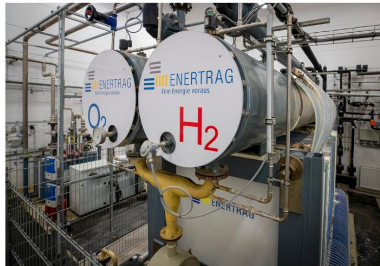
Elektrolyseur des Hybridkraftwerks der ENERTRAG in Prenzlau. © ENERTRAG photo
