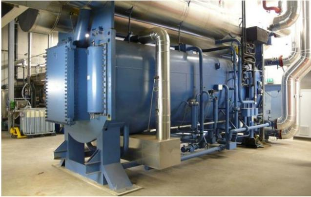
Einsatz von Absorptionskälteanlagen nur bei vorhandenen Abwärmequellen mit Abwärme auf hohem Temperaturniveau und großer Menge sinnvoll !
